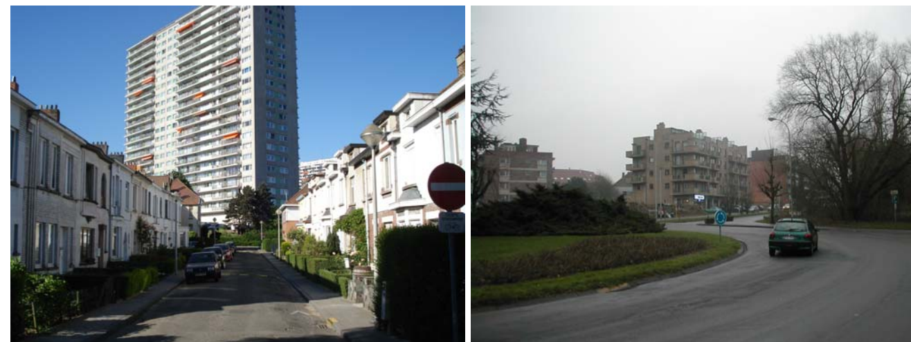
Figuur 132 – I. contrast hoogbouwwijk – arbeiderswoningen – II. nieuwe invullingen langs Van Overbekelaan
