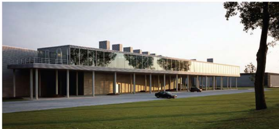
HOOFDZETEL RENSON > JO CREPAIN WAREGEM
