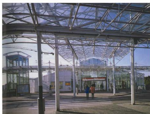
METROSTATION VUOSARI HELSINKI
