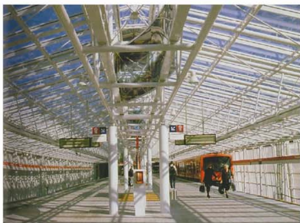
METROSTATION VUOSARI HELSINKI
