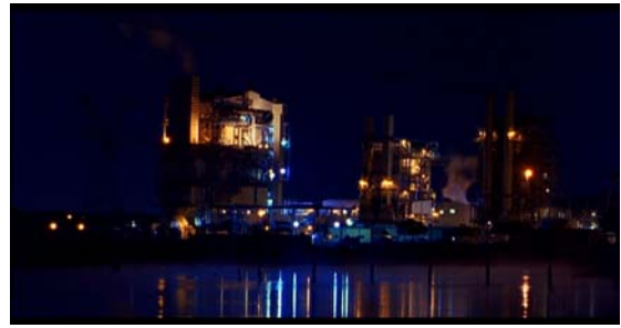
Figuur 15: Falls City by night: een droomplaats?
