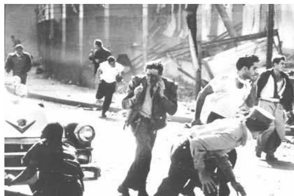
De ravage in de dokken van de haven vlak na de explosie.
