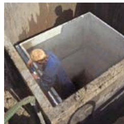
Betonbak bij installatie
